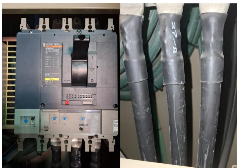
Ilustración 2.interruptor automático y alimentación eléctrica.
