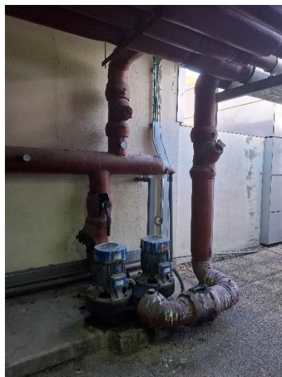
Ilustración 4. Grupo de bombeo y puente hidráulico de accesorios a sustituir.
