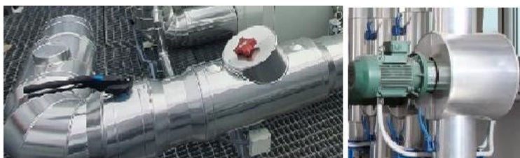
Ilustración 5. Ejemplos de Aislamiento térmico en tuberías y bombas.
